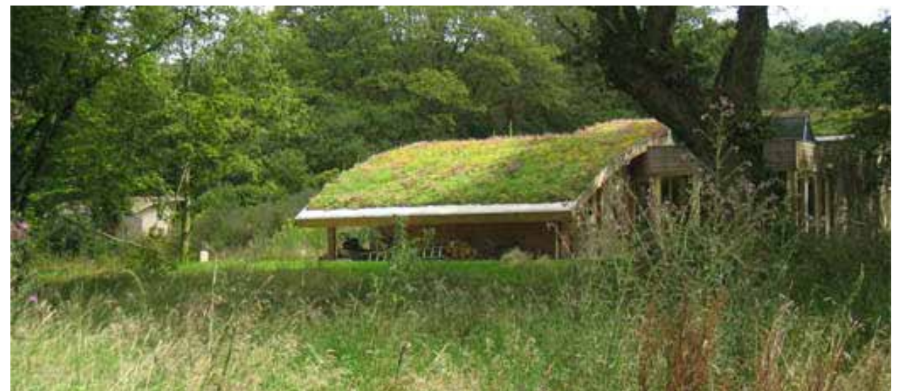
Groen dak als opslag hemelwater
